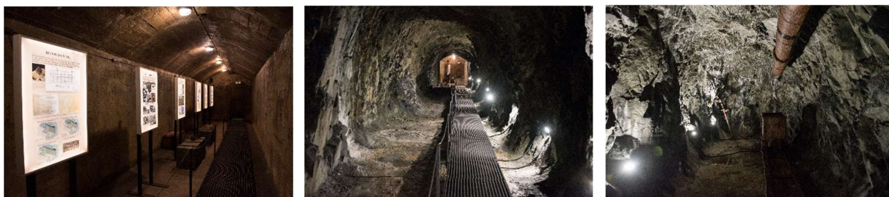
Zleva: infopanely ve vyztužené části štoly, nevybetonovaná část – pohled vždy směrem ke vchodu. Vpravo pohled na čelbu, na stropě patrná roura ventilačního zařízení
